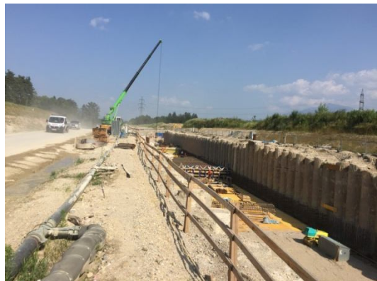
Blick in Richtung offener Tunnelabschnitt
